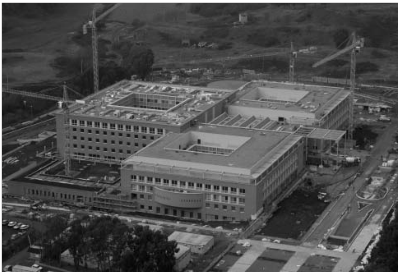
Foto 1: Vista generale del Policlinico Universitario Campus Bio-Medico in costruzione
